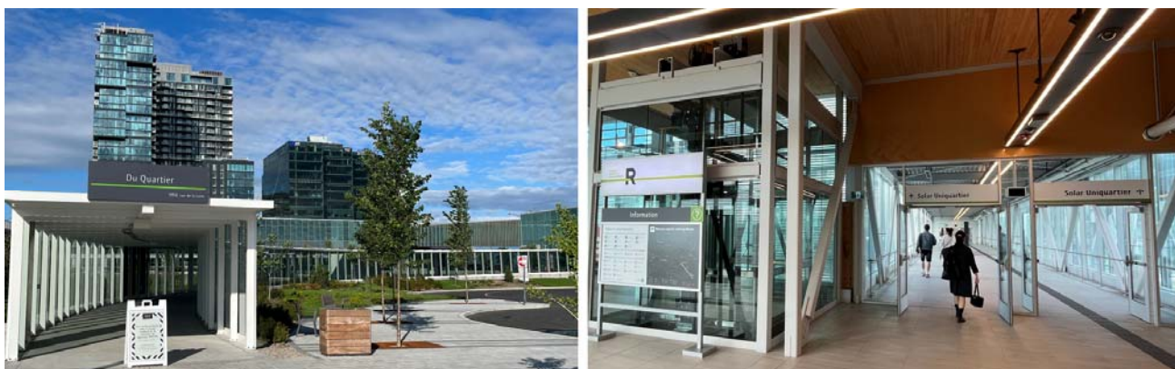
Figure 4 et 5 : La passerelle dédiée pour connecter SU et REM
