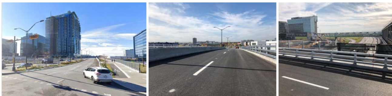
Figure 6, 7 et 8: Viaduc du Quartier
