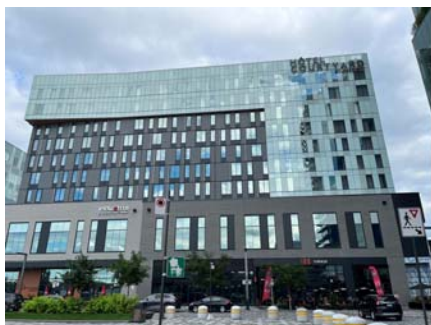
Figure 12 : L'hôtel COURTYARD Source : Photos prises sur place
