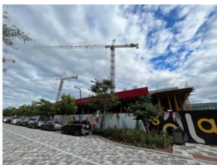
Figure 16 : NORTERA en construction
