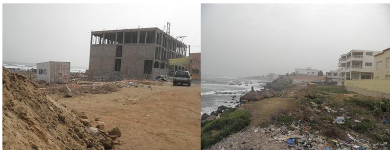
Photo 3 et 4. Construction de résidences et d'un hôtel au niveau du « Virage »
