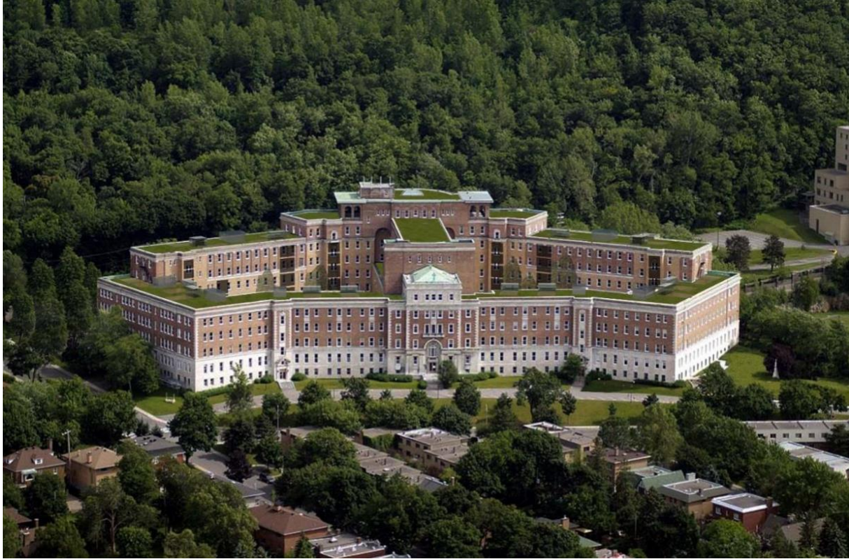
Figure 12 : Maison de la mère des Sœurs de la Congrégation Saints Noms de Jésus et de Marie. Il est maintenant connu sous le 1420 et a été acquis par un promoteur privé, Catania (La Presse, 2012).
